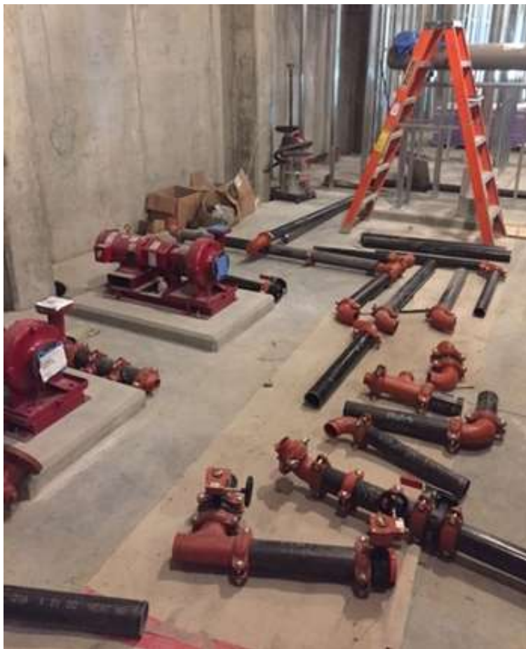
Ricezione elementi prefabbricati
