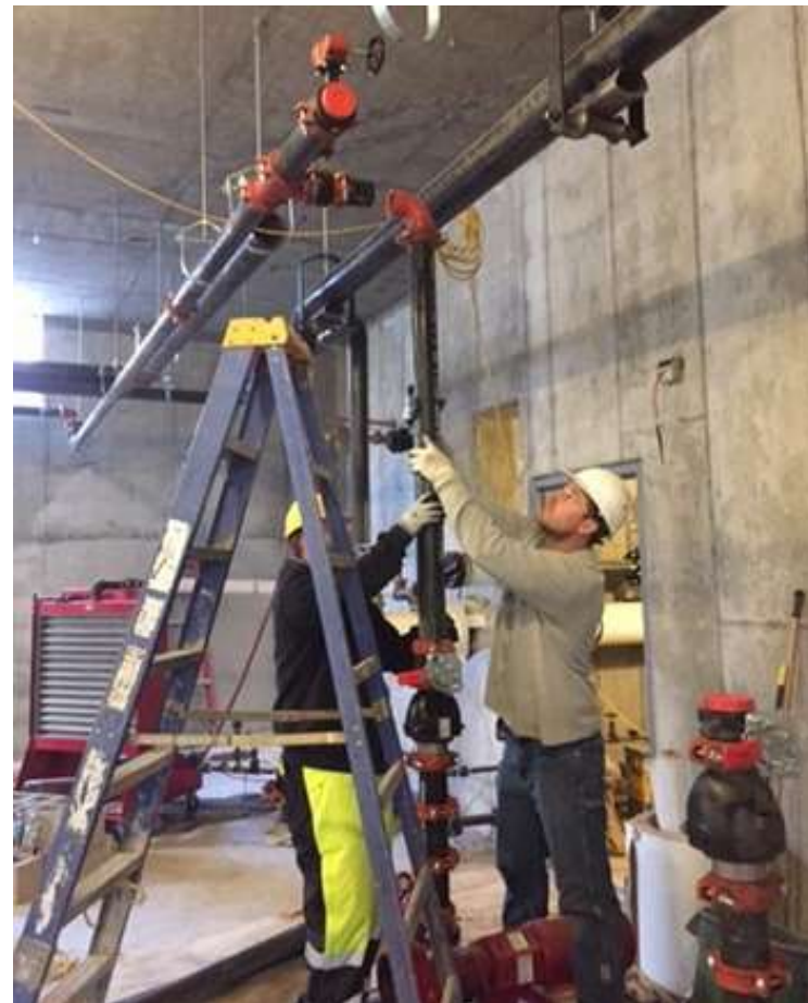
Installazione degli assiemi
